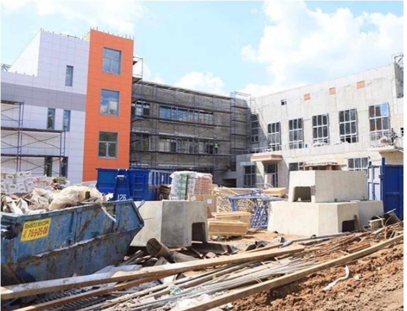
Общий вид строящегося объекта (пристройка к зданию МАОУ «Гимназия № 9», г.о. Королёв, Кооперативная, д. 1)
