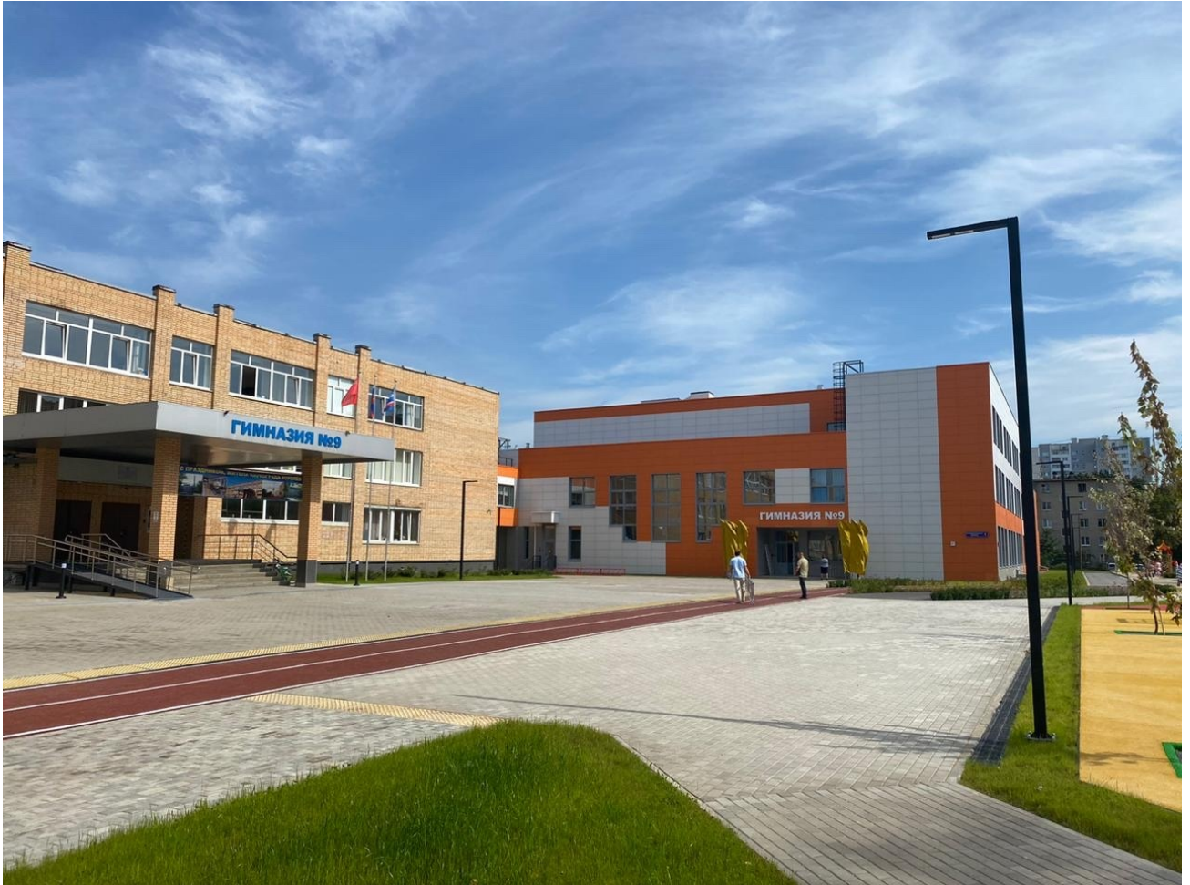
Общий вид строящегося объекта (пристройка к зданию МАОУ «Гимназия № 9», г.о. Королёв, Кооперативная, д. 1)
