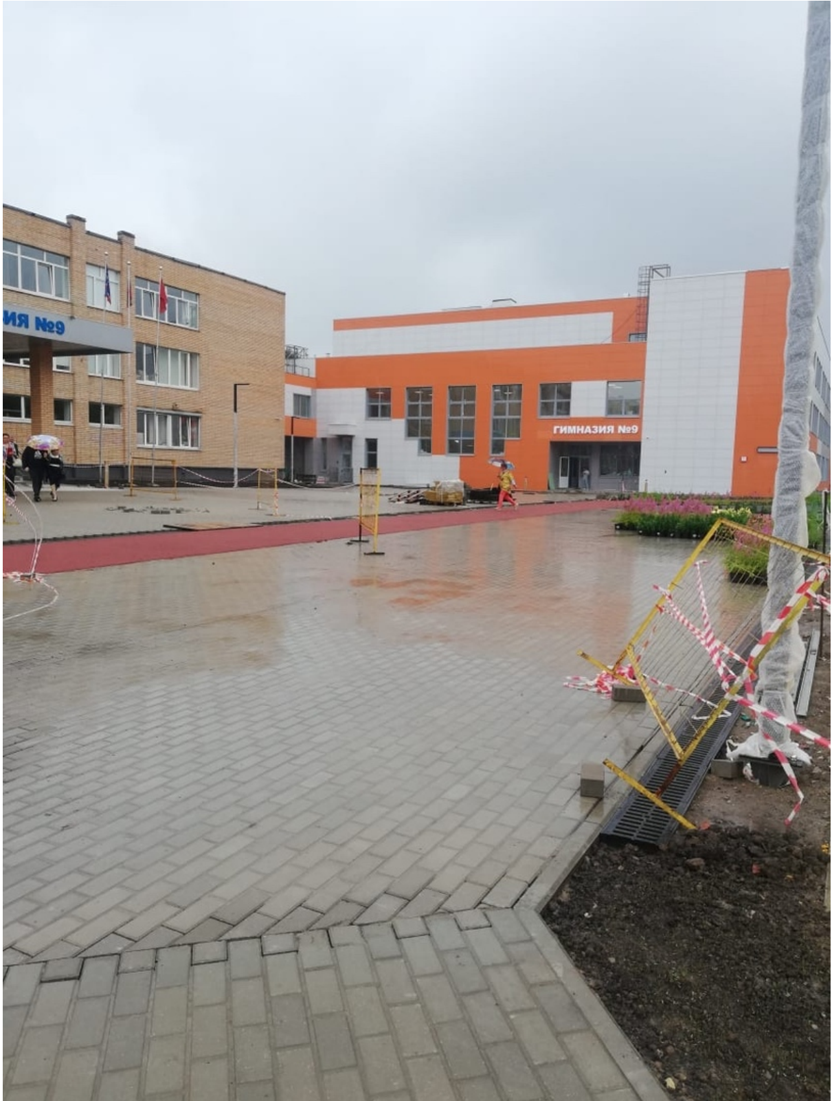
Общий вид строящегося объекта (пристройкак зданию МАОУ «Гимназия № 9», г.о. Королёв, Кооперативная, д. 1)
